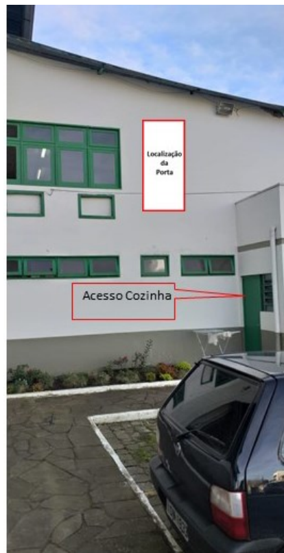
FIGURA 2 – ILUSTRAÇÃO DO LOCAL DA OBRA COM FRENTE PARA UMA ÁREA DE ESTACIONAMENTO
