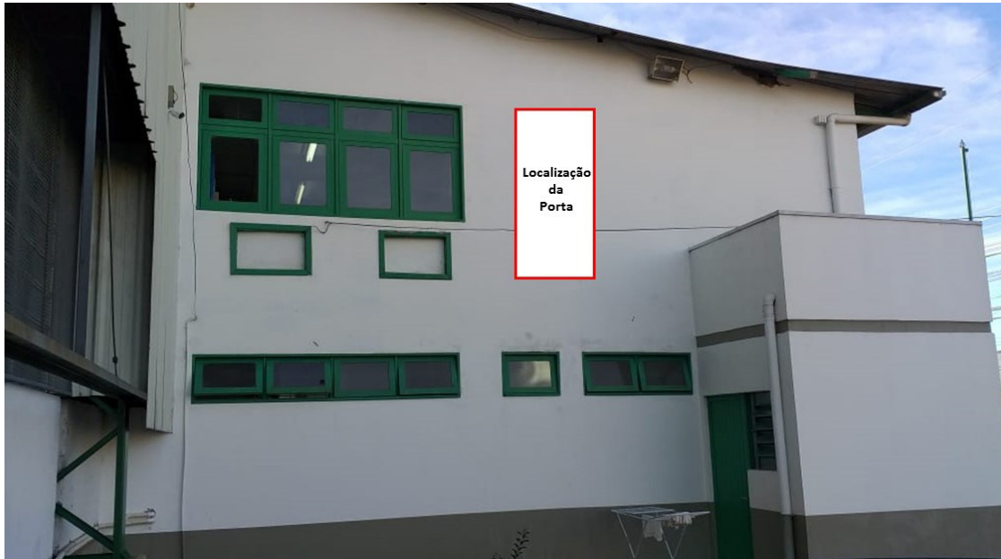
FIGURA 1 – PAREDE (LATERAL DIREITO DO PRÉDIO ADMINISTRATIVO)
